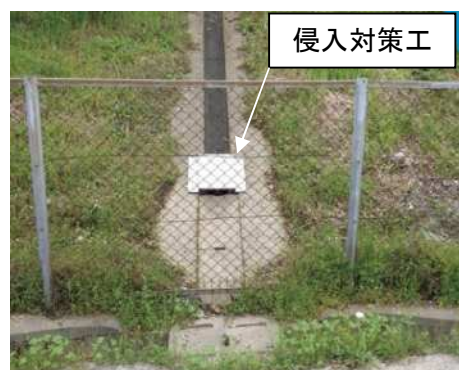
写真-2 排水溝侵入対策
