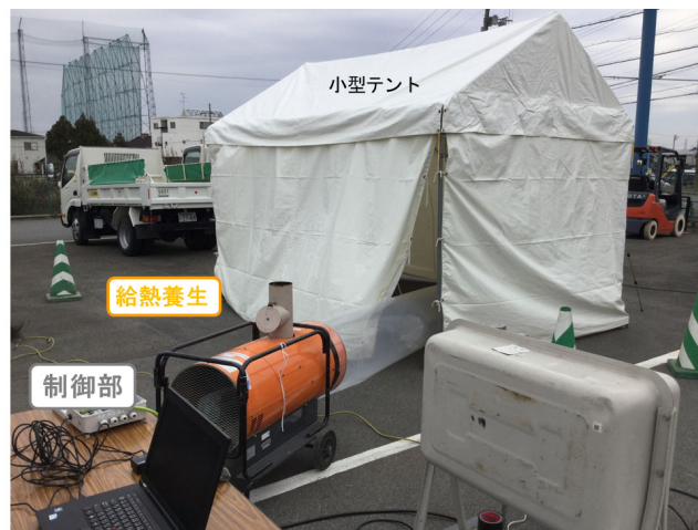
写真-2 給熱養生実験状況
