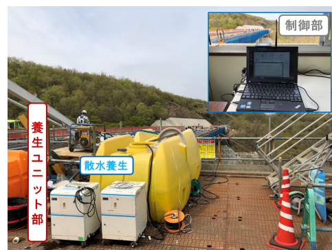
写真-1 現場での自動散水養生例
