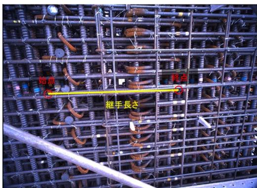
写真5 重ね継手長さ計測状況
