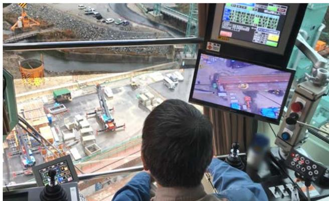
図-4 ダムコンクリート自動運搬状況
