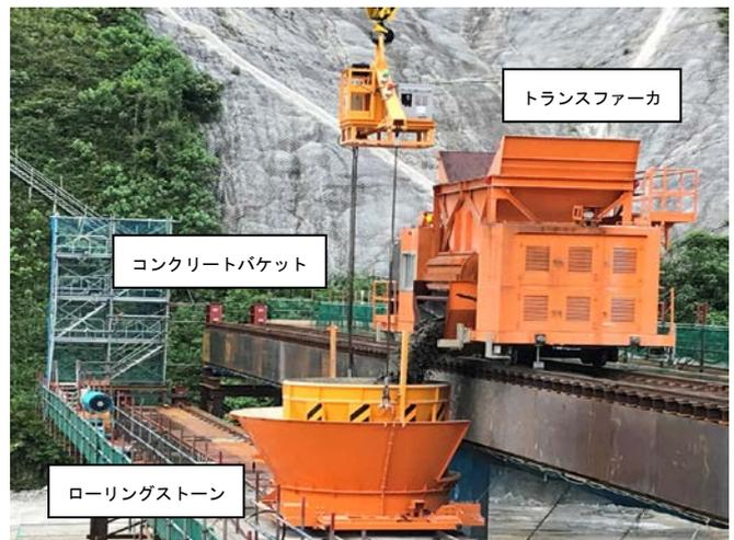
図-2 バンカー線上設備
