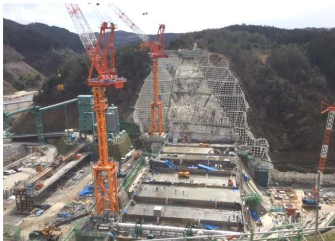
図-5 ダムコンクリート自動運搬状況
