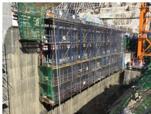
図-3 自動スライド型枠設置状況
