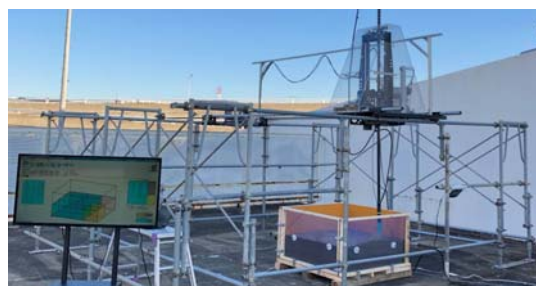
写真-2 動作確認試験状況
