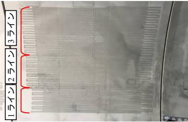
写真－7 研掃面仕上がり状況
