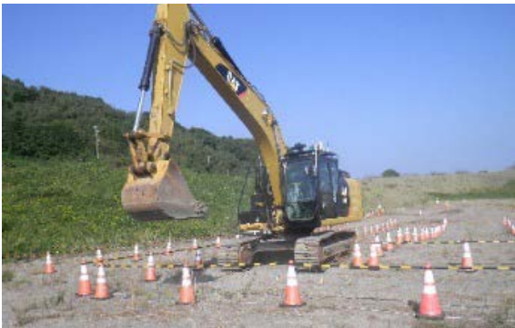
写真 3 走行正確性検証状況
