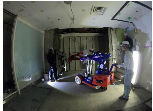
写真1 鋼板設置マニピュレータ
