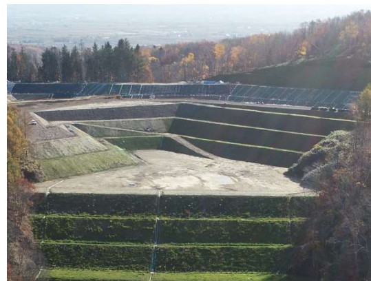
写真-3 No. 3 土捨場盛土完了
