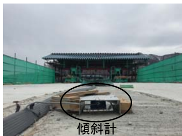
写真-2 橋面傾斜計設置
