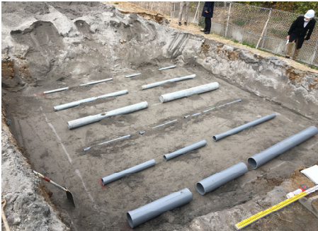
図-1 GL-1.0mでの埋設管敷設状況
