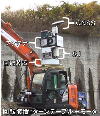
写真-1 正対装置搭載状況
