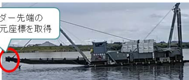
(写真4) ラダー先端のカッターヘッド
