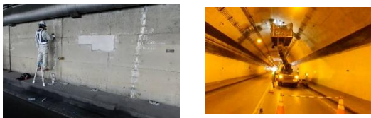
図7 安全 PT の実施状況 図8 高所車両の作業
