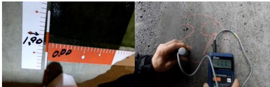
図5 仕上がり精査 図6 表面含水率の確認
