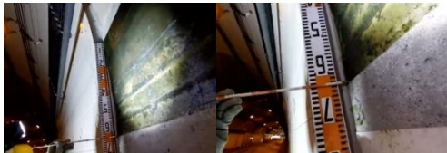
図9 剥落防止シー ト出来形確認 図10 剥落防止シート拡大図
