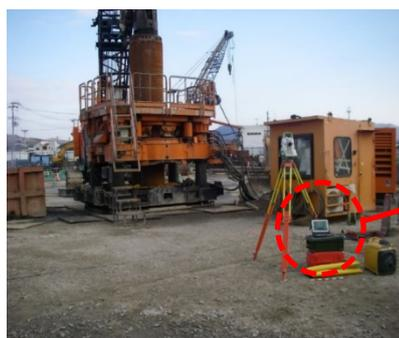
写真1 場所打ち杭施工状況
