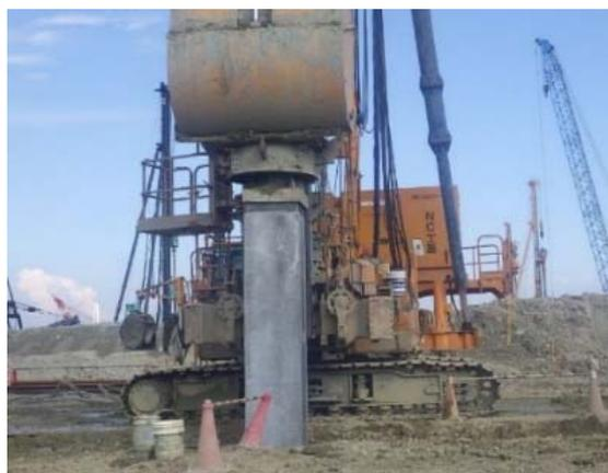
写真1 PC-壁体打設状況
