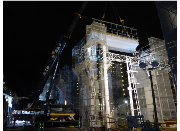
写真-1 ハーフプレキャスト架設状況
