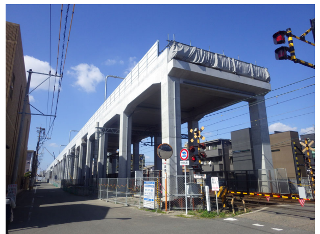
写真-3 終点側から全景
