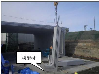
写真-2 側壁底面の緩衝材
