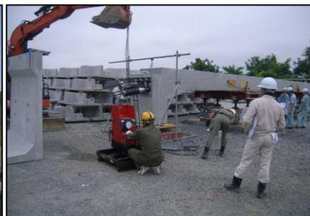
写真-3 頂版の試験緊張状況
