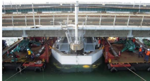
図-1 仮締切（NDR）設置状況
