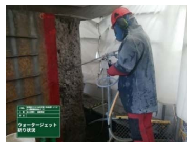
図-2 コンクリート撤去（WJ）
