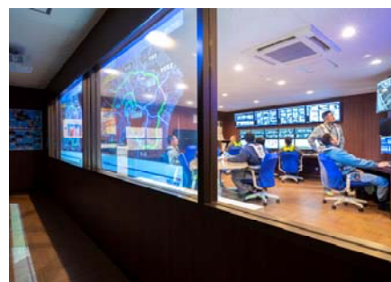
写真-5 中央操作室
