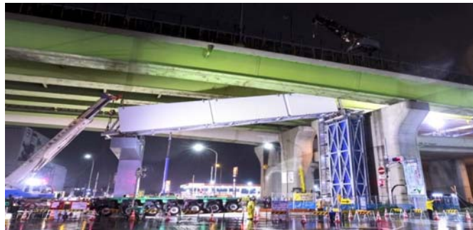
写真-3 国道・県道交差点における実施工状況
