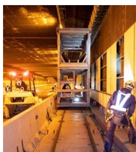
写真-2 移送状況
