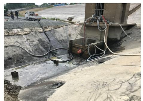
写真-6 泥土撤去完了状況
