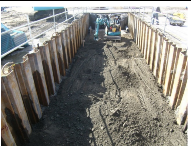
写真-3 ウェルポイント排水工法 本施工状況
