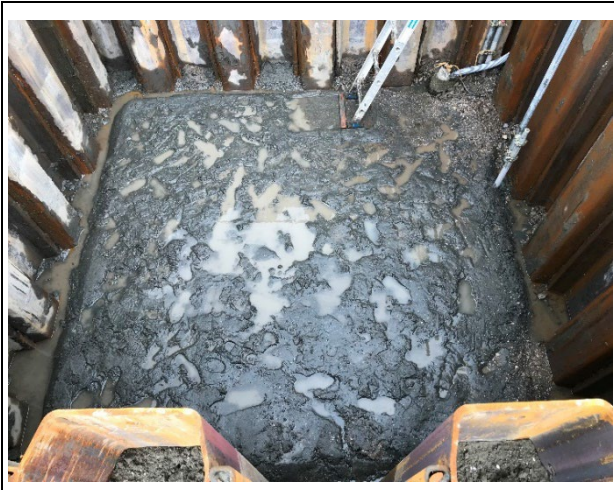
写真-2 釜場排水 試験施工状況
