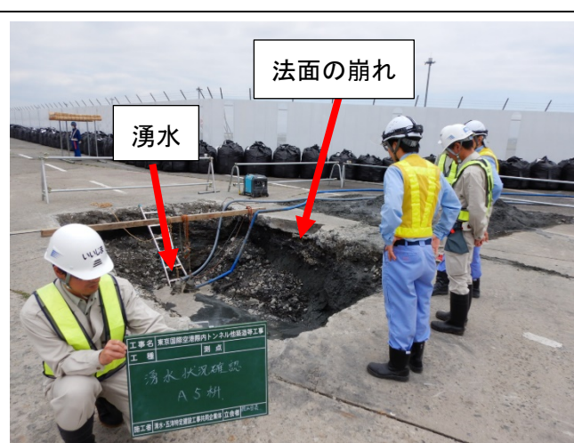
写真-1 試掘時の状況
