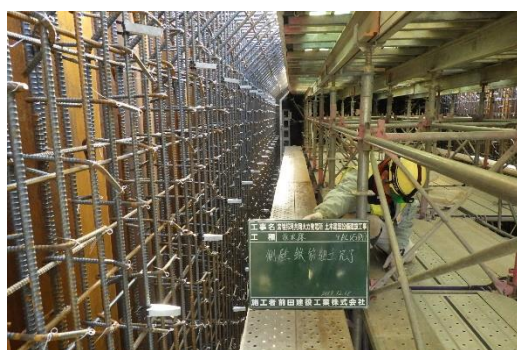
写真-3 鉄筋用足場(内部)
