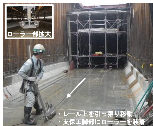
写真-4 型枠支保工移動状況
