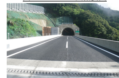
写真-4 上部工完成
