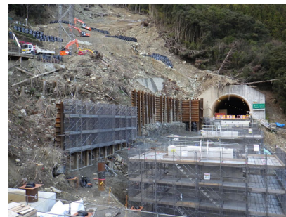
写真-2 仮設落石防護工全景
