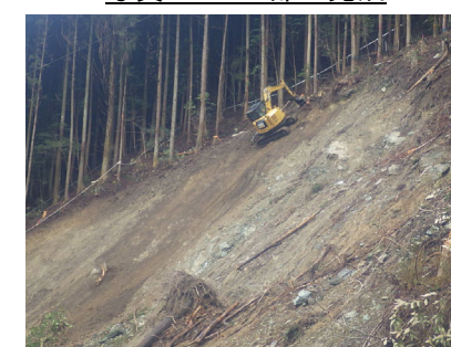
写真-5 SCM 施工状況
