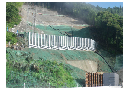
写真-3 流向制御工全景
