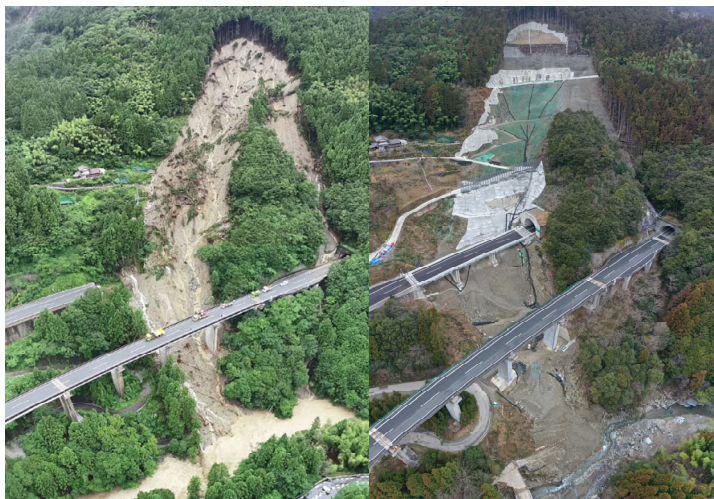
写真-1 災害直後(左)と復旧完了後(右)
