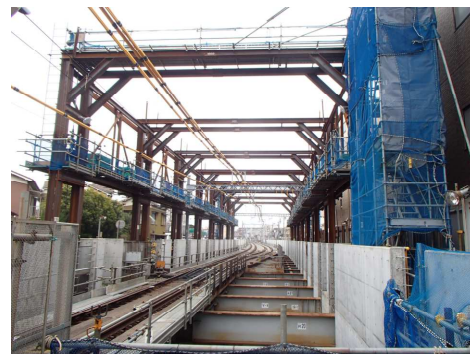
写真-1 扛上設備設置状況
