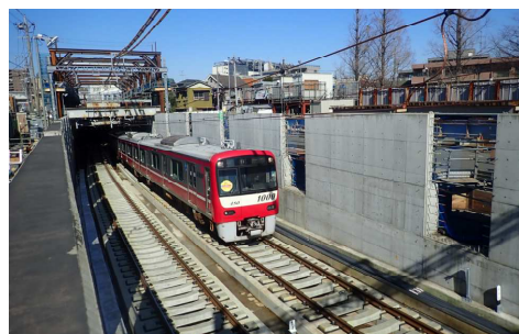
写真-3 線路切替完了
