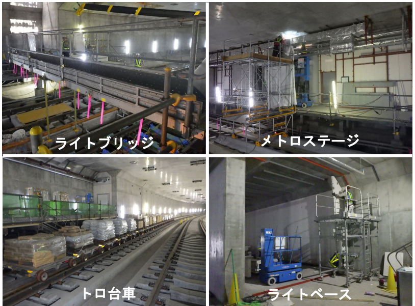
写真-1 使用した仮設資機材の写真
