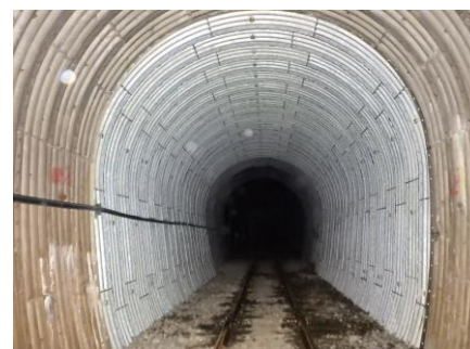
写真-2 ライナープレート施工後
