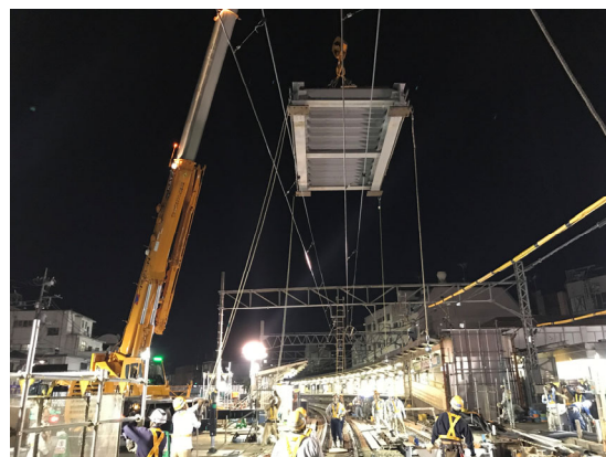
写真-1 架設状況
