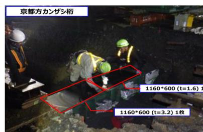
図-7 調整プレート挿入
