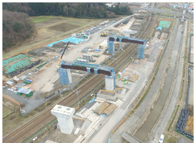
写真-2 鋼製馬桁仮設完了
