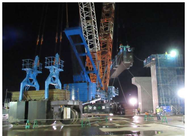
写真-1 鋼製馬桁仮設状況
