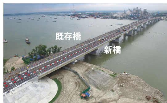
写真-3 メグナ第2橋の開通時全景
