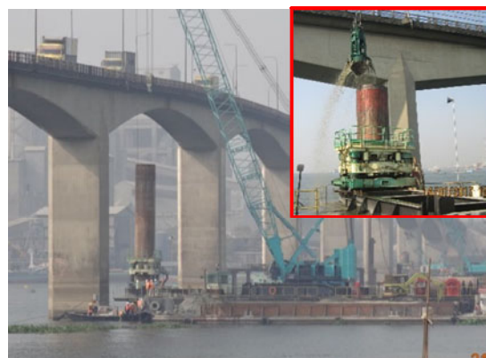
写真-1 CD工法による撤去状況
