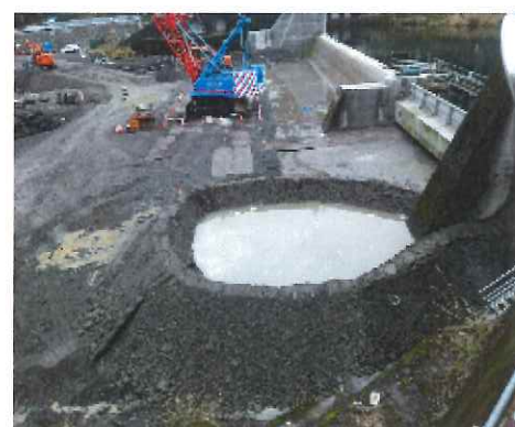
写真-4 盛土堰堤施工完了
