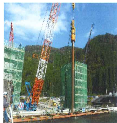
写真-3 鋼管矢板施工状況
