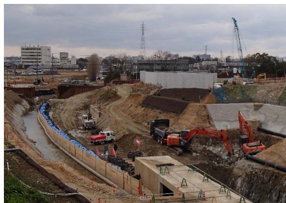
写真 3-1 第二段階仮水路写真
