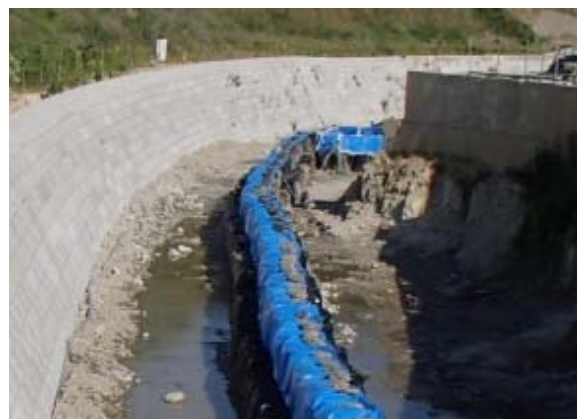
写真 3-2 第二段階仮水路写真
