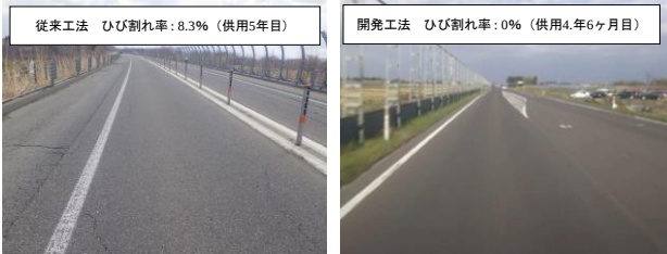
a) 従来工法(現場 A) b) 開発工法(現場 B)
