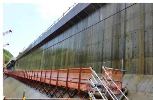
写真-3 打込み後の状況 (下流左岸側より)
