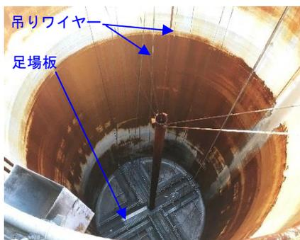
写真-6 サウンディング試験用の吊り足場
