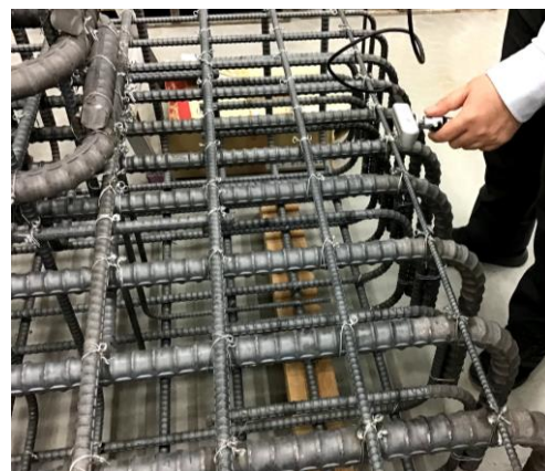
図-3 鉄筋の測定状況
