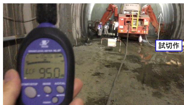
写真-1 トンネル切羽付近の騒音計測結果
