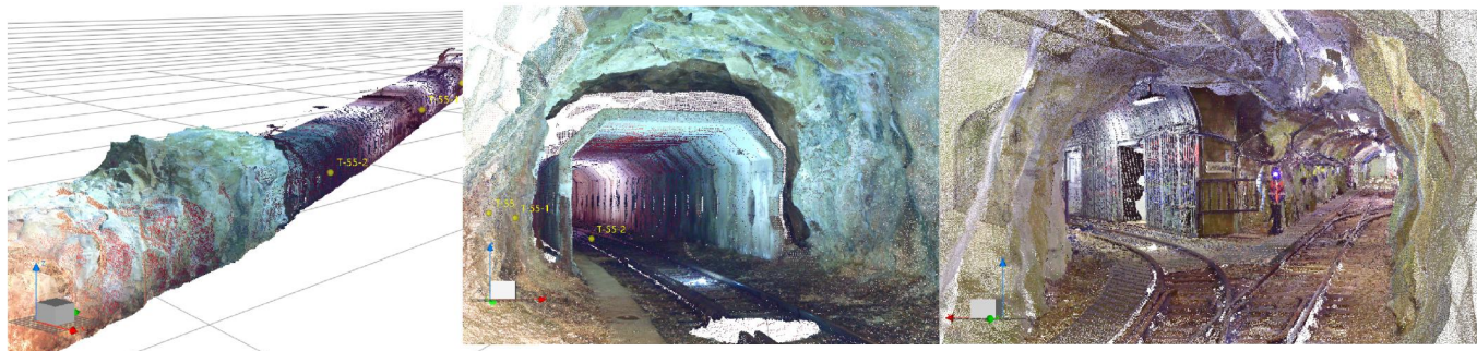
図-3 トンネル内空点群データ(左,中央:高熱隧道部,右:トンネル内空)
