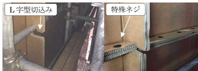
写真-2 固定加工と接合部材
