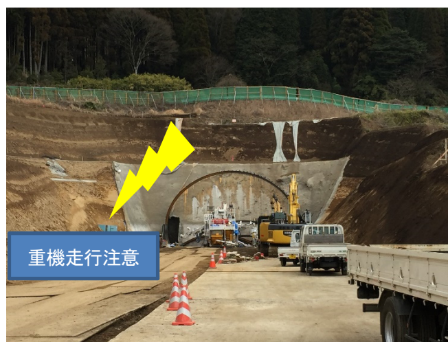
図-3 現場の状況
