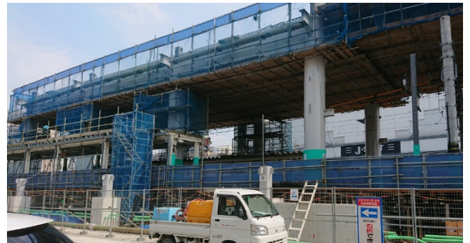
図-4 建設中の新駅舎付近の現場状況
