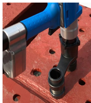
写真-2 反力治具使用状況
