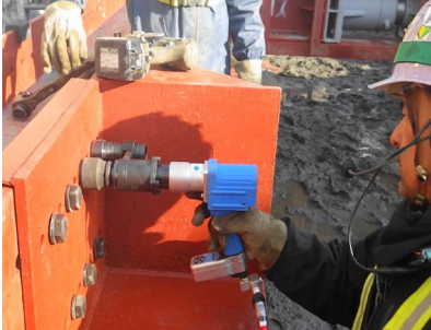
写真-4 現場適用状況 (1)
