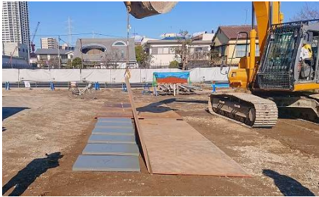
写真 2 マット敷設状況
