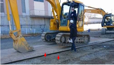
写真 3 加振状況（0.45BH 衝撃時）
