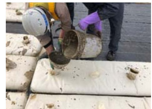
写真-4 不透水性土のうへの充填
