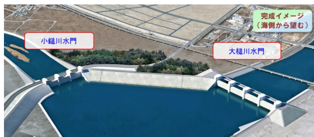
図-3 試行対象現場 (大槌川・小槌川水門工事: 防潮堤)
