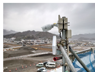
図-5 定点カメラ等の設置
