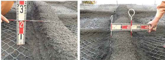
図-6 吹付け厚管理の概要
