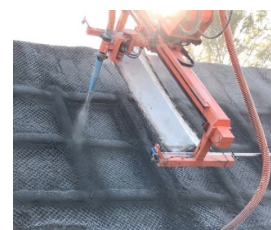
写真-5 吹付け装置
