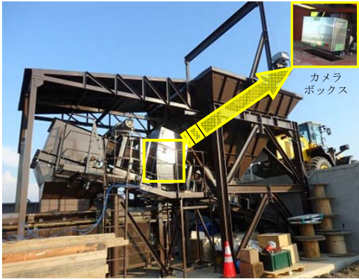
写真-1 AI システムのベルトフィーダへの設置
